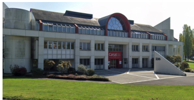
Les locaux de la Carsat Bretagne, à Rennes. © Capture d'écran Google Street View
