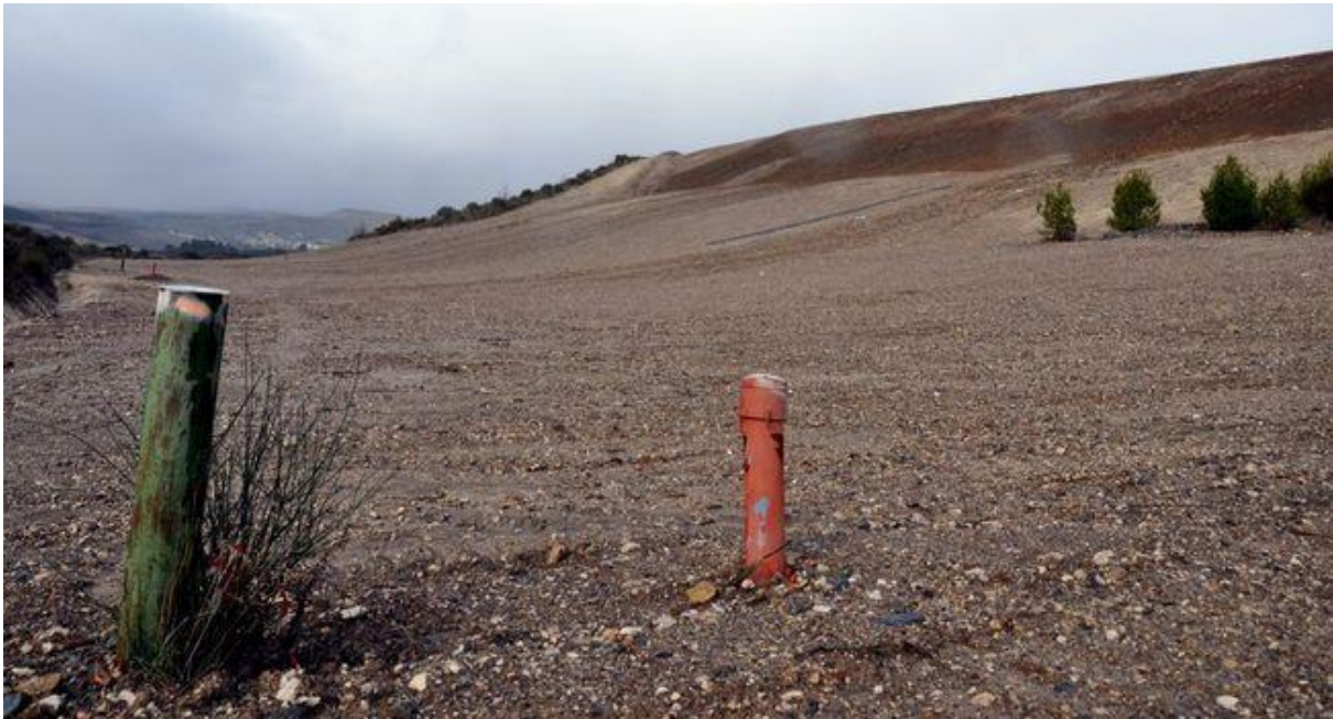
Le flanc Ouest du stockage de Montredon, des inclinomètres permettent de vérifier la stabilité du dépôt./ Photo DDM, B.H.
